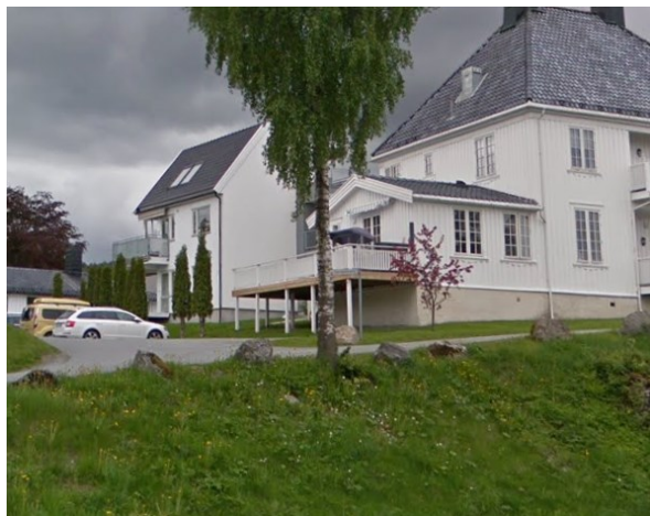
下部を通行可能な大きなバルコニー → 天蓋(キャノピー)記号を使用する
