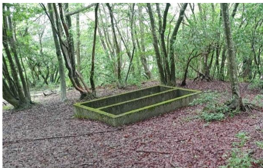
バンガロー跡の基礎コンクリート
